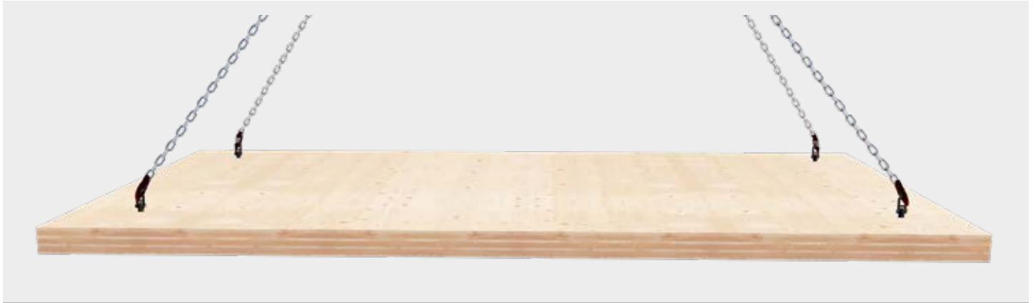
Horizontaler Transport von z. B. Deckenelementen.
