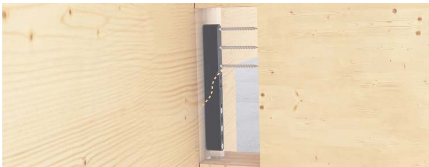
Montageverbinder zur Montage einer Wand an einer zweiten, bereits stehenden Wand.
